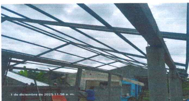
Foto 3: Se observa la colocación de ventanas.
