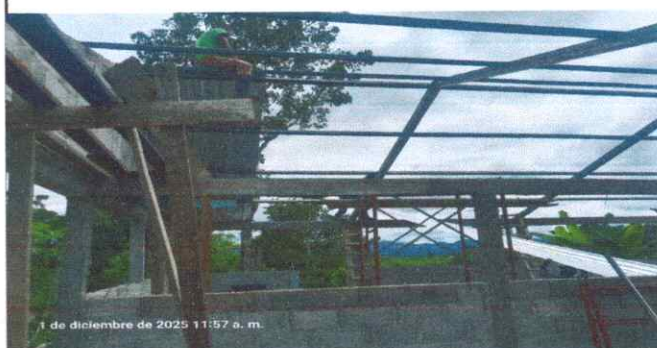
Foto 2: Se observa el inicio de la colocación de las laminas.
