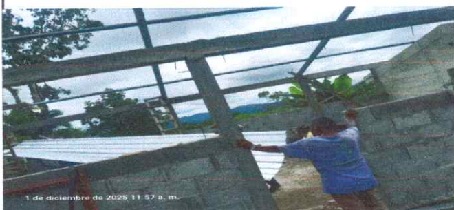
Foto 5: Se observa la colocación de las vigas.
