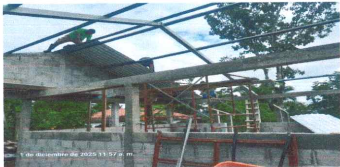
Foto 1: Construcción de la pared perimetral de la cocina.
